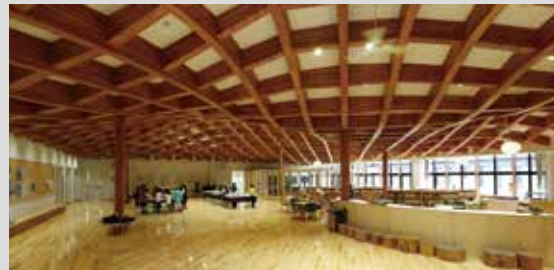
小学校 使用樹種／トドマツ、カラマツ、カバ、シナ Elementary school Wood species used／Todo fir, Japanese larch, birch, linden
